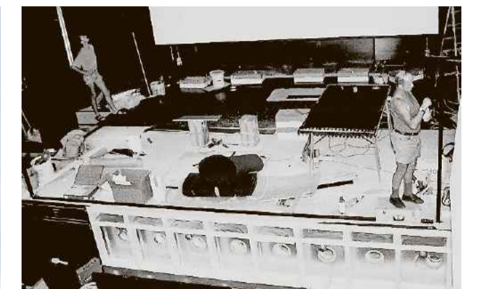
Nach dem Kauf gingen die Renovation und der Umbau über die Bühne. (LOUIS PROBST/ARCHIV AZ)
