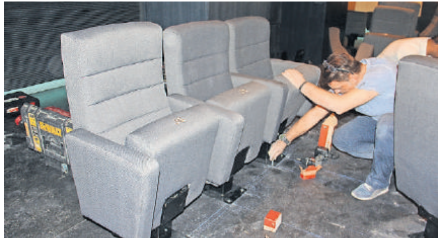
Im Brugg «Odeon» werden am Freitagnachmittag die neuen Sessel montiert. CM
